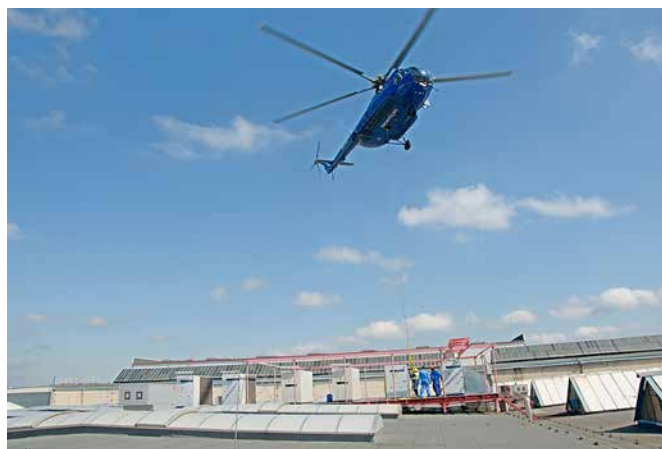
Obr. 8 Nastěhování jednotky na střechu výrobní haly
