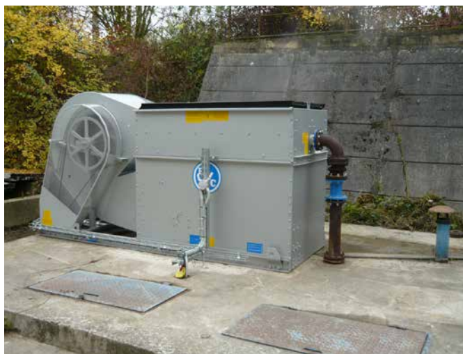
Obr. 3 Tlakově otevřená chladicí věž firmy Baltimore.
