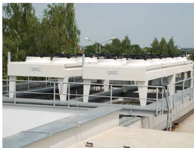
Obr. 2 Suché chladiče Alfa Laval – stolové provedení.
